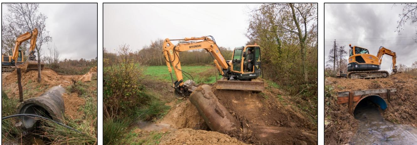
*Suppression d'une buse – Installation d'une arche en PEHD 1400 mm – Ruisseau du Crochet – P. Loridon - 2019*
