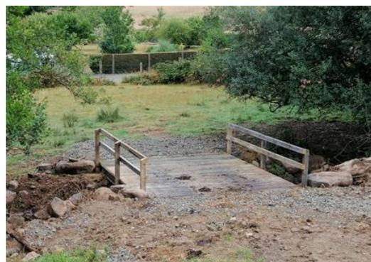
*Suppression d'une buse – Installation d'une passerelle bétail – Bassin du Moulin Besnard – P. Lorida – 2020*
