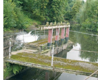
Ouvrage sur le Noireau
