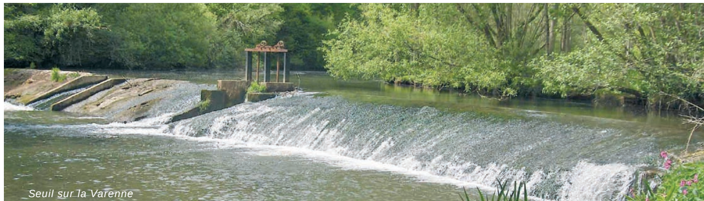
Seuil sur la Varenne
